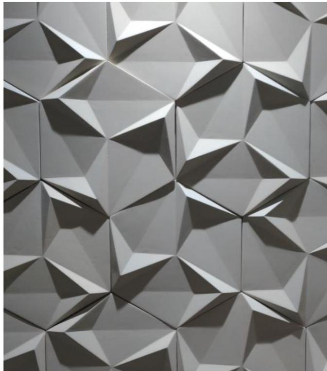
Figura 21 – efeito com utilização de rejunte e pintura da mesma cor
