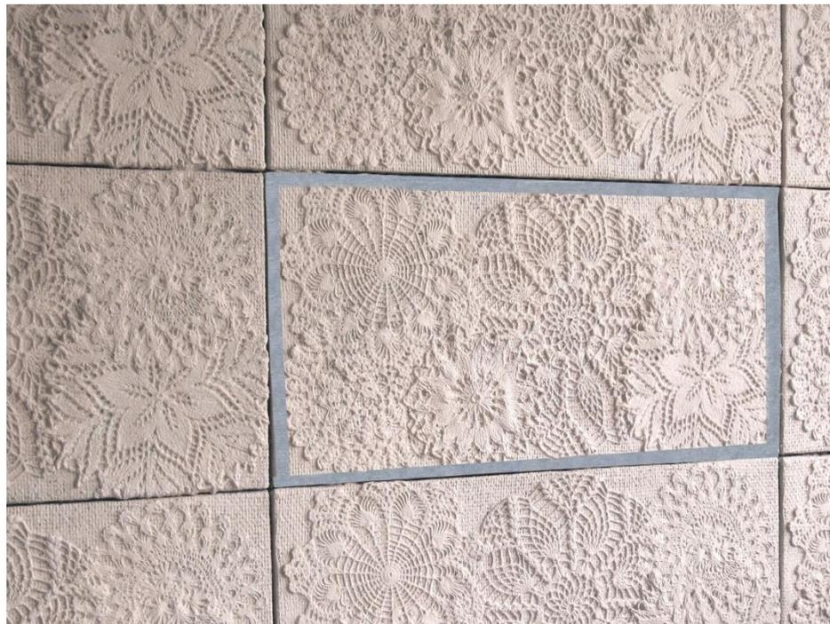
Figura 20 – aplicação de fita crepe nas bordas para rejuntamento
