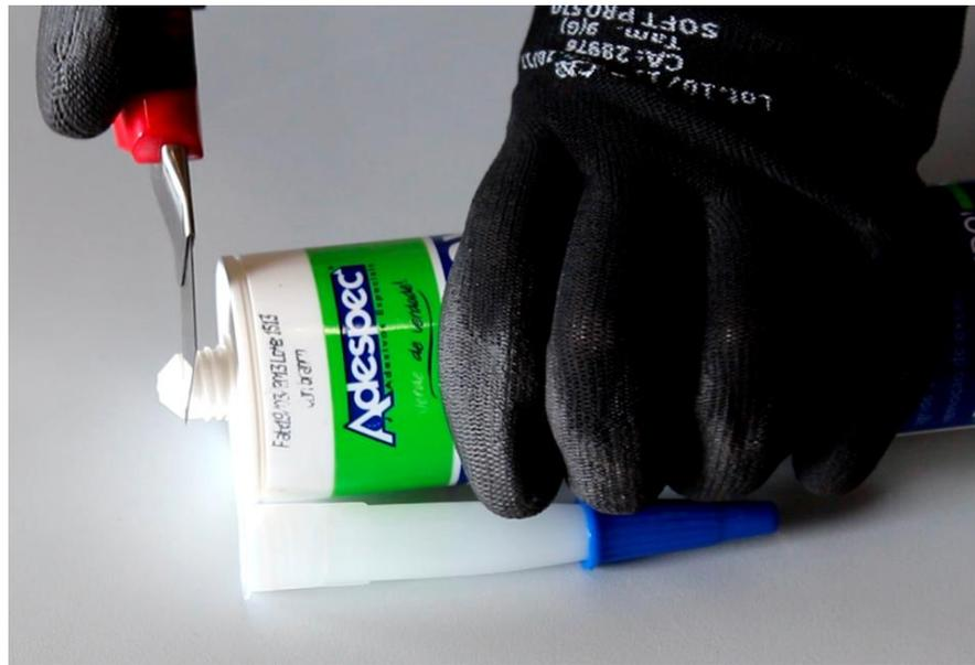
Figura 04 – corte do bico do adesivo
