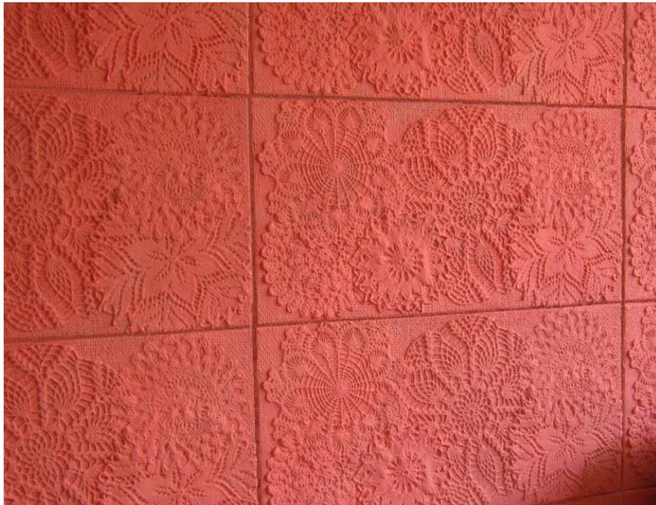
Figura 22 – efeito com utilização de rejunte e pintura da mesma cor
