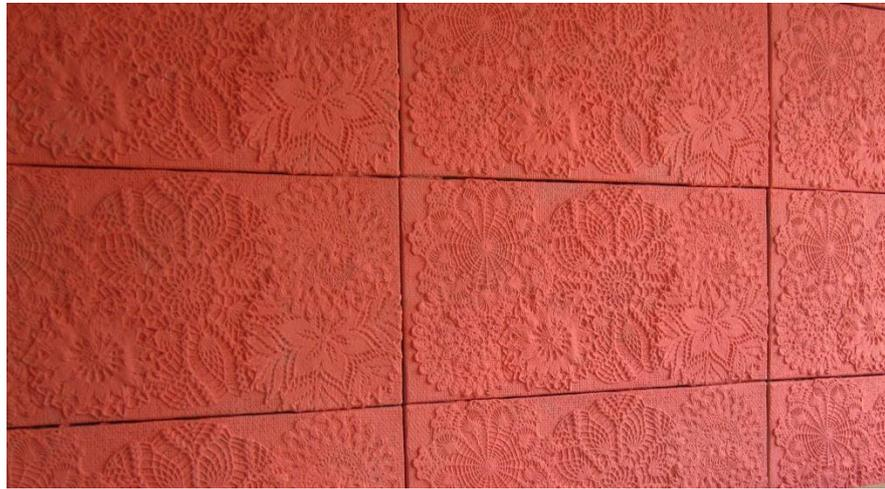
Figura 18 – assentamento junta seca (sem rejunte)
