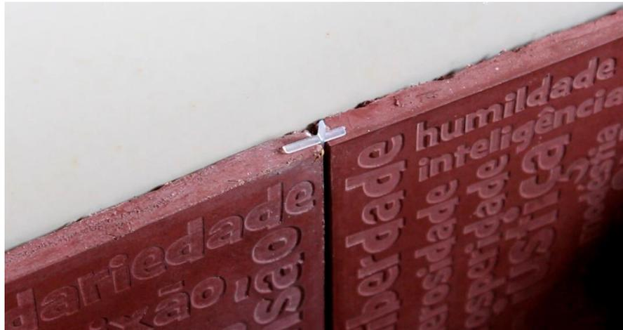
Figura 16 – espaçador plástico 1mm para junta seca
