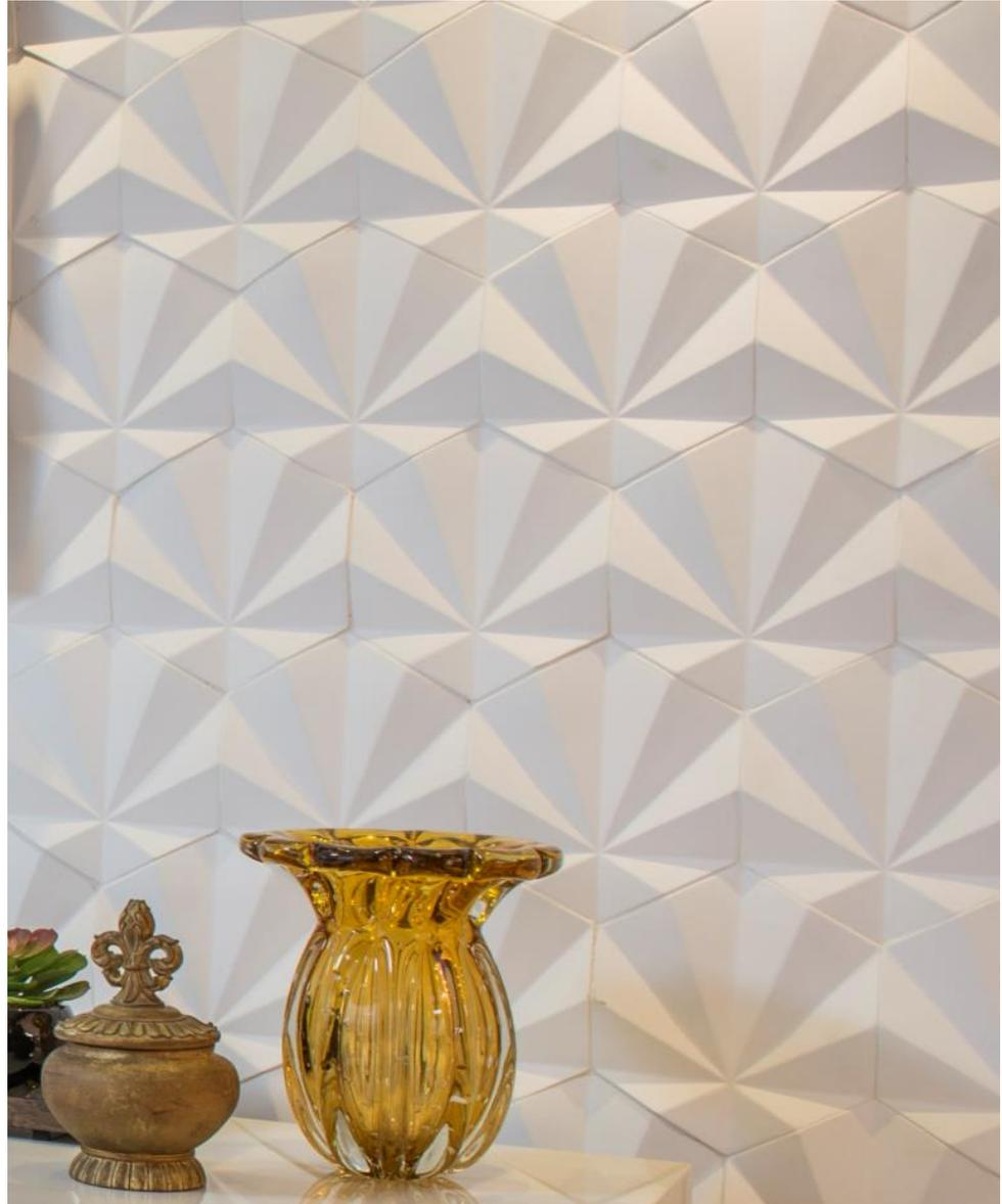
Figura 19 – efeito com utilização de rejunte e pintura da mesma cor
